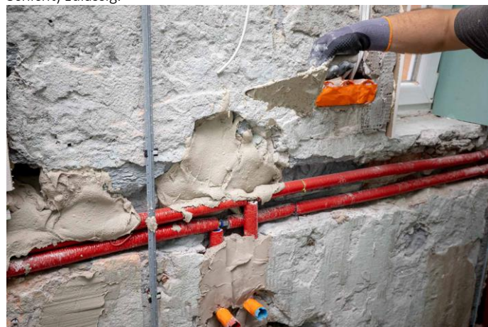
Ausbessern von Installationsrillen.
