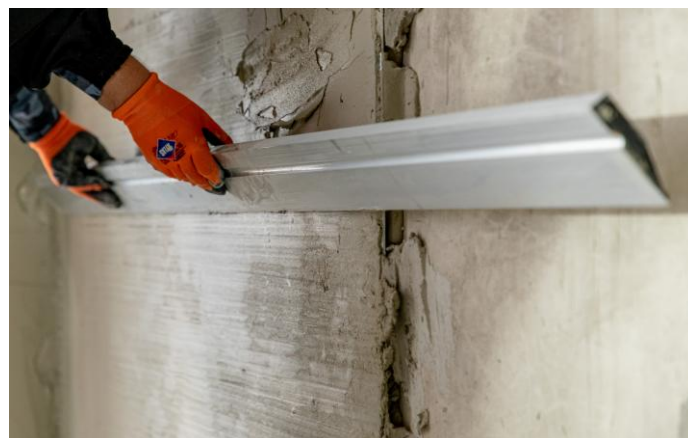
Auftragen des Putzes ATLAS NEXUS.
