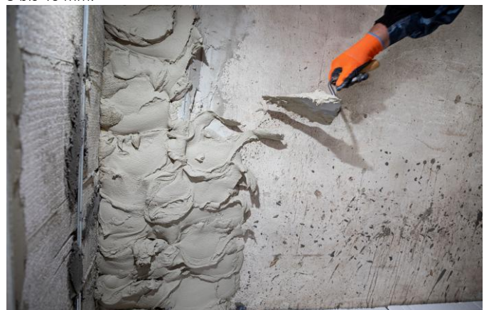
Auftragen des Putzes ATLAS NEXUS.
