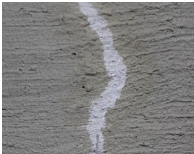
Fot. 4. Uzavření trhliny krystaly soli, bez úniku vody. Účinek po 21 dnech.
