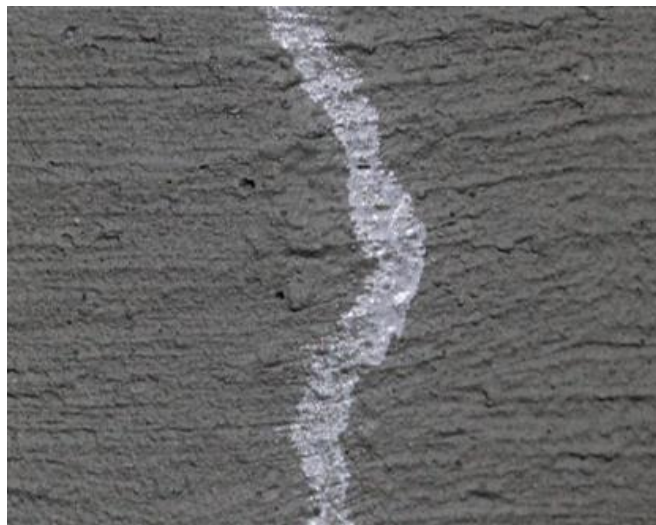
Fot. 5. Pomalý růst krystalů soli na povrchu trhlín, finální utěsnění. Účinek po 35 dnech.
