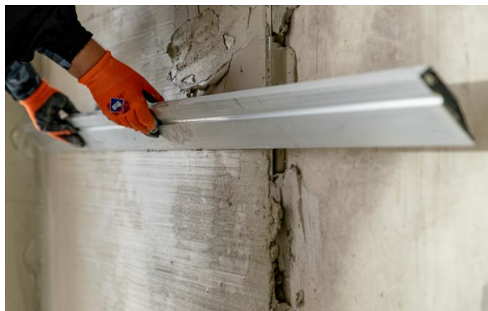
Нанесення штукатурки ATLAS NEXUS.
