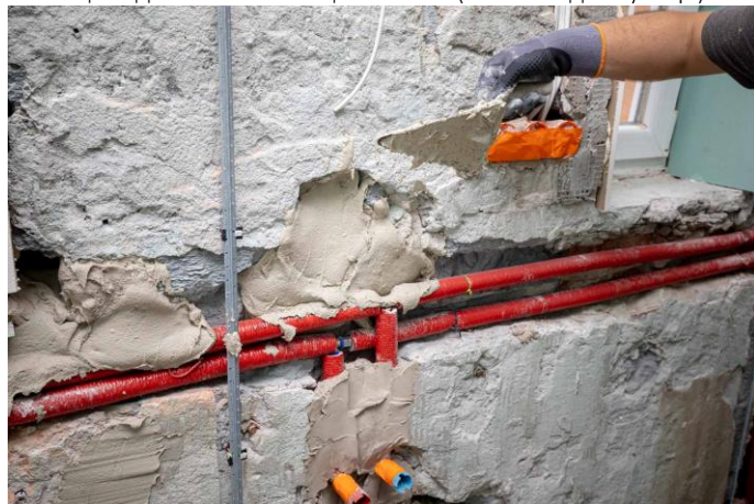
Заповнення монтажних швів.
