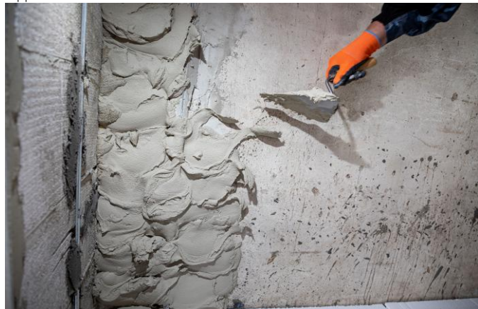
Нанесення штукатурки ATLAS NEXUS.
